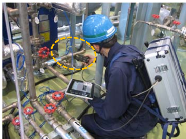
図-1 配管振動応力の非接触測定
