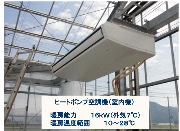
実証試験用栽培ハウス 設計基準 風速 36 m/S, 積雪 32 kg/㎡ ハウス規模 間口 14 m × 1棟 × 72 m、面積 1,008 ㎡
