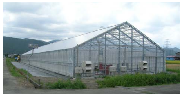
実証試験用栽培ハウス 設計基準 風速 36 m/S, 積雪 32 kg/㎡ ハウス規模 間口 14 m × 1棟 × 72 m、面積 1,008 ㎡
