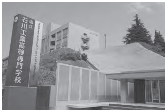
図1 新しくなった石川高専の正門
