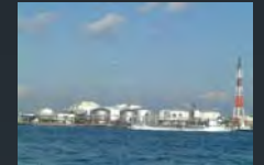
東横ゼネラル石油(株)川崎工場(川崎区岸島)
