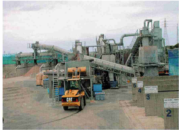
図1 ガラス造粒砂（サンドウエーブG）製造プラント
