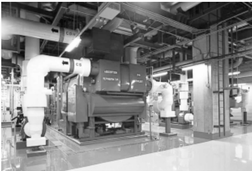
図3 蒸気二重効用吸収冷凍機
