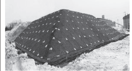
図1 パーク材により被覆した雪の山 (北海道沼田町)
