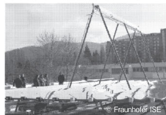
図4 リニアフレネルソーラーコレクタ
