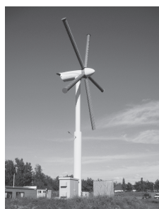
図4 完成した直径 11.5m スパイラルマグナス
