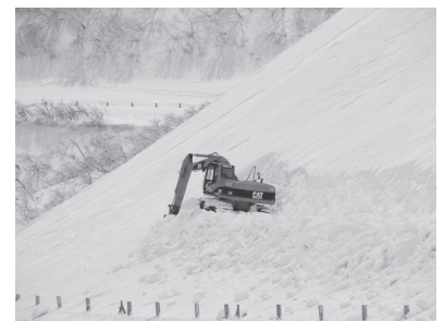
図2 バックホーによる除雪作業
