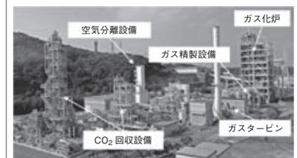
図 3 EAGLE パイロット試験プラント (電源開発 (株) 若松研究所)
