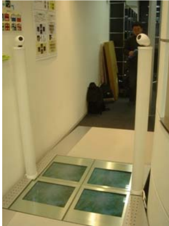
図2 顔画像認証によるセンサ連動デモンストレーション設備
