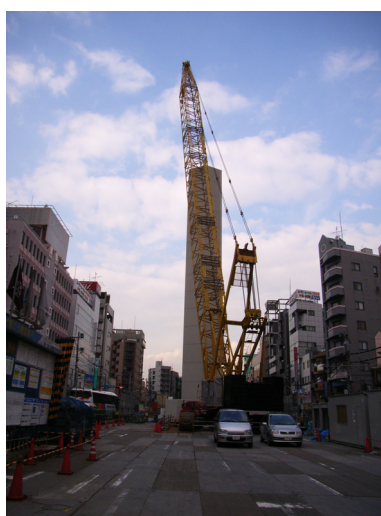
Fig.1 建設中の東中野換気塔
