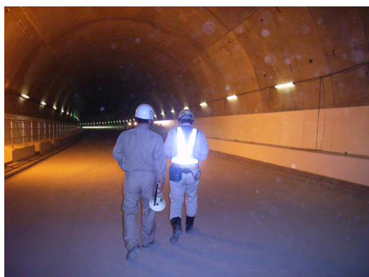
Fig. 2 シールドトンネル内部
