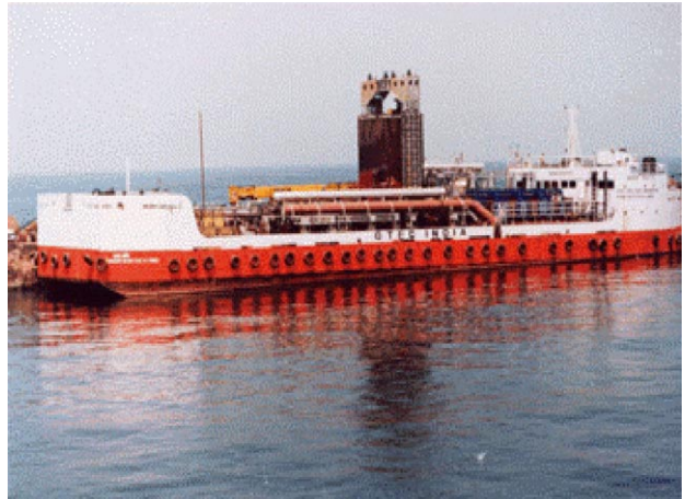
図2 1000kW 海洋温度差発電実証プラントの全景
