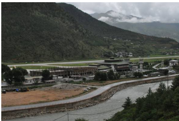
写真1 緑の山に囲まれたパロ国際空港
