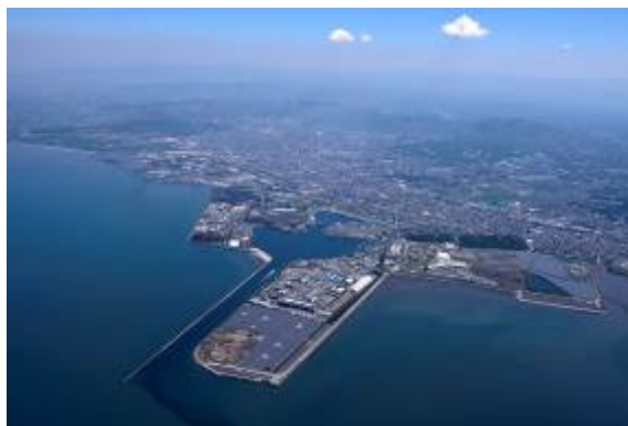
三池港(上空から)
