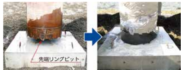
図3 鉄筋コンクリートの鉄筋を切断して貫通させた状況
