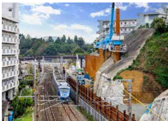
図1 ジャイロパイラーによる鉄道近接の切土擁壁築造工事
