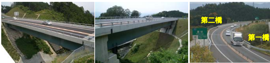
第一橋【50m：ダンパ無し】 第二橋【60m：ダンパあり】 橋梁全体
