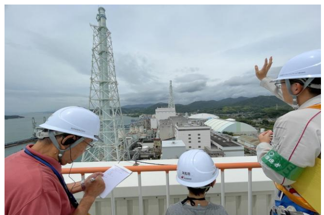
新1号ボイラ建屋の屋上から 旧1, 2 及び 3号機を臨み竹原火力の歩みを学ぶ 3号機は現役でフル稼働中
