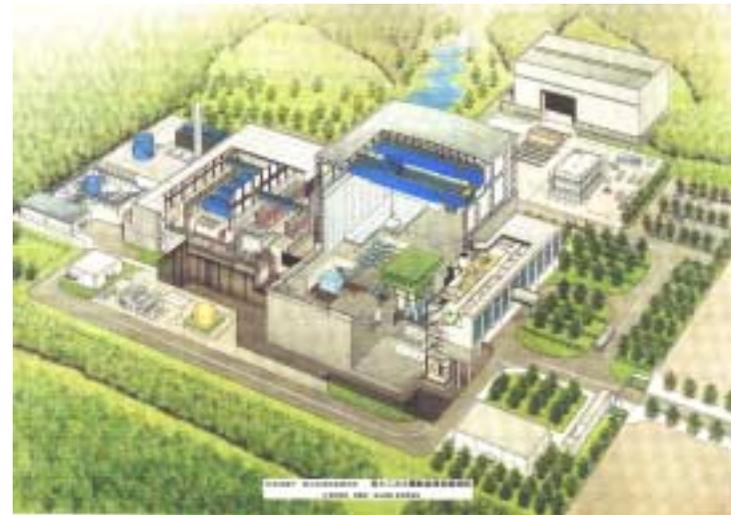
図3 独立行政法人防災科学技術研究所が兵庫県三木市に建設中の1200ton 3-D震動台*E-defense*完成図
