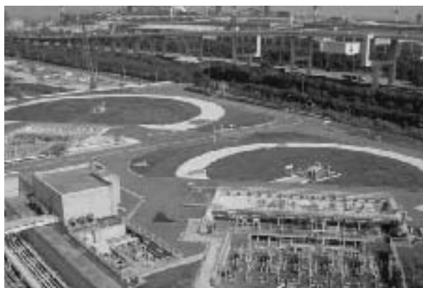
20万KL完全埋設式地下LNGタンク
