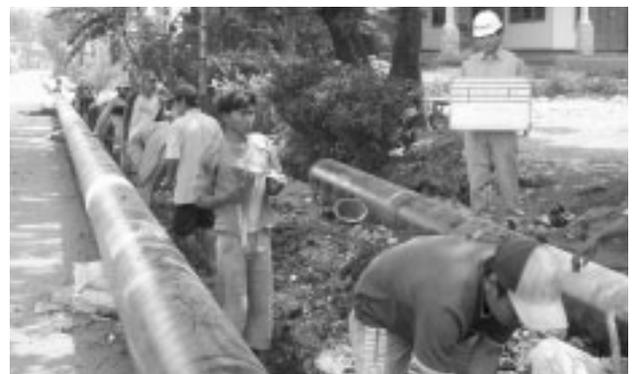
写真1 人海戦術により掘削作業をする様子
