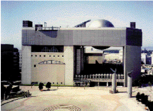
図1 日立シビックセンター外観
