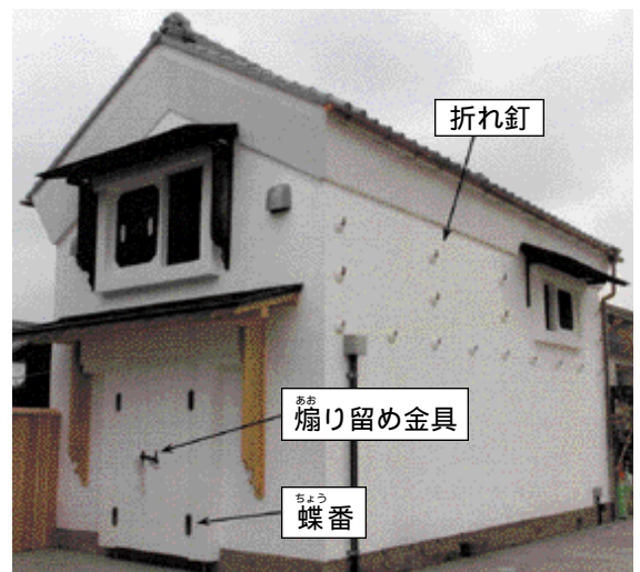
図4 改修工事後の蔵
