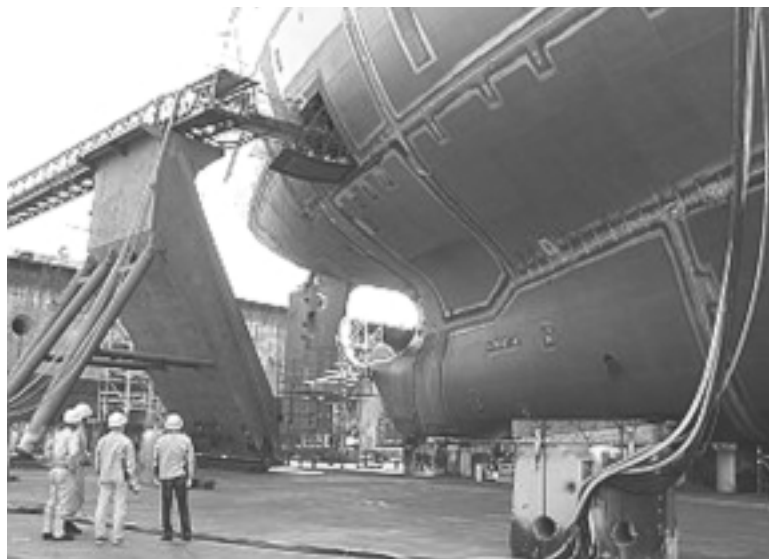
図1 建造ドック内で組立中のAFRAMAX
