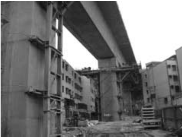
図8 非常に狭い場所での高架橋建設（単純桁型）
