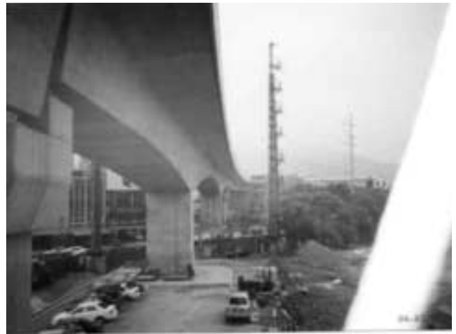
図9 高架橋の形状の違い（カンチレバー型）
