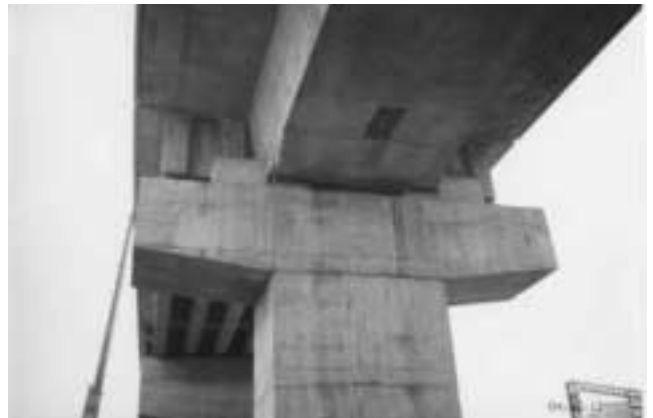
図5 高架橋の形状の違い(支柱の手前は大林・互助JVが手がける高架橋)
