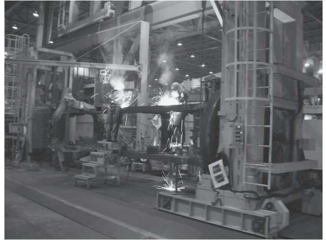
図2 フレーム部の溶接のようす
