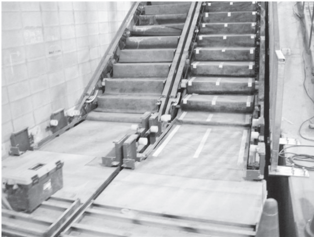
図3 工事中的のエスカレータ
