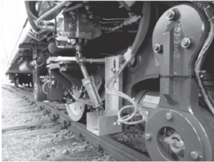
図3 アシスト操舵台車に取り付けられている機械式のリンク
