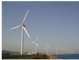
エヌエスウインドパワーひびき
