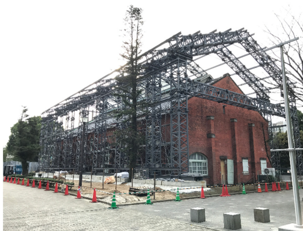
図1 熊本大学 工学部研究資料館
