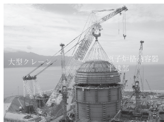
大型クレーンによる原子炉格納容器半球部の一体化吊込み(平成17年9月)
