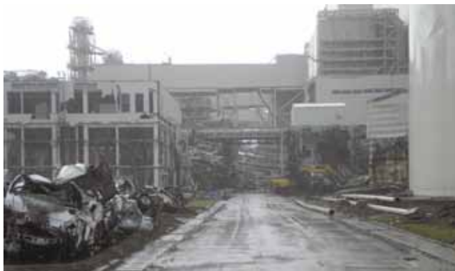
図2 原町火力発電所津波被害状況 (南の構内道路より1号機を撮影)
