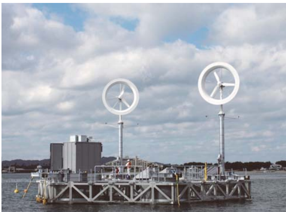
図5 博多湾海上浮体と 3kW 風レンズ風車 2基と ソーラーパネル 2 kW (浮体直径 18m)
