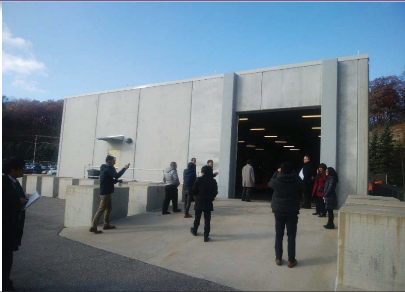
DCクック発電所のFLEX機器格納庫
