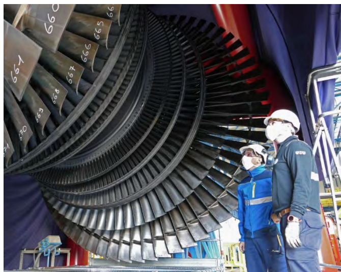
図 3.2-12 シボー原子力発電所1号機における停止中の保守作業の様子
