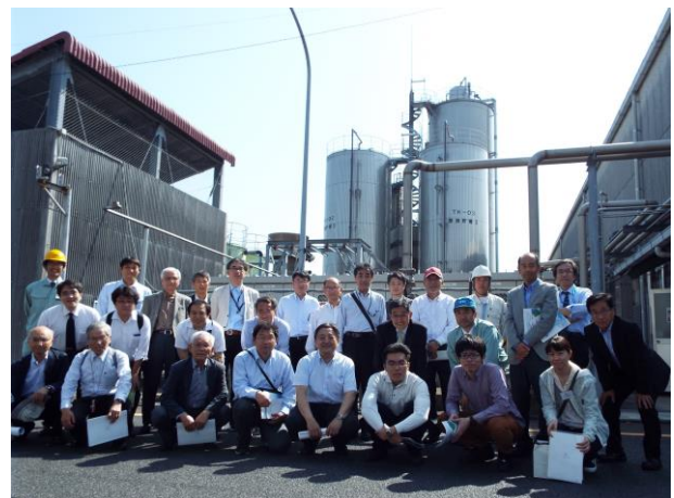
サザングリーン協同組合 (バイオマス発電施設)
