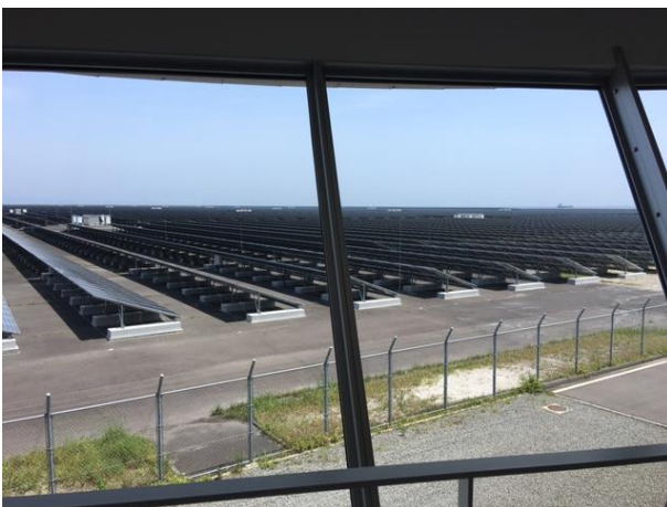
七ツ島メガソーラー発電所
