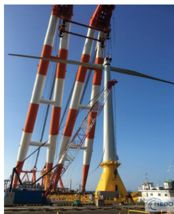
図4 地組した風車の設置状況 1)
