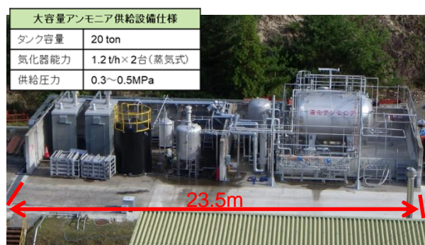
図 1 大規模アンモニア供給設備
