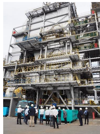
えひめ森林発電・発電所ボイラ前にて
