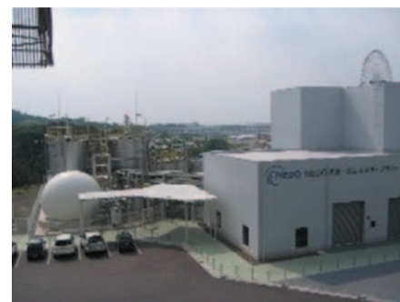
メタン発酵施設全景
