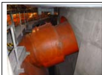
図 5.1.3 ベント管溶接部
