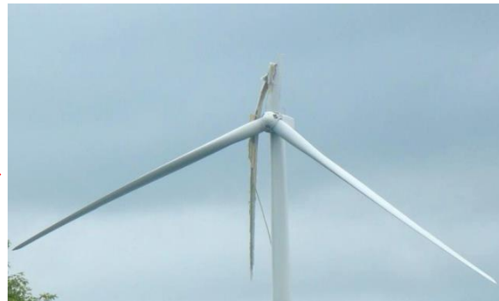
激しい暴風雨によって破損したブレード
