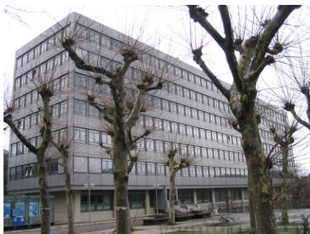
図4. 研究棟 (ITVは3階)
