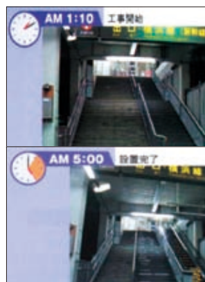
超短工期設置工法の進行状況
