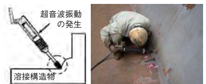
図1 UIT処理のイメージと施工の様子
