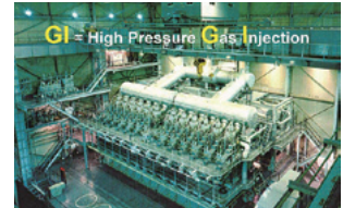
図3 GI方式低速ディーゼル機関の陸上発電プラント適用例
