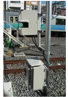
図4 列車停止位置検知装置
