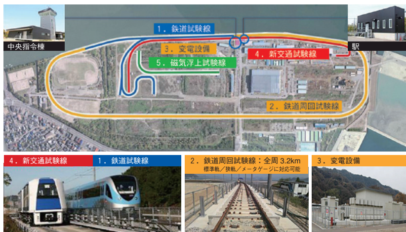
図1 施設の概要と建設状況
