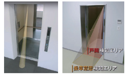
図1 赤外線センサ（左図）と画像センサ（右図）の検出エリア
