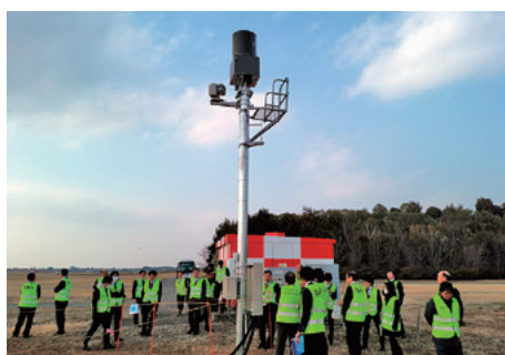
図 3 アンテナ局路面装置 A の設置状況概観
